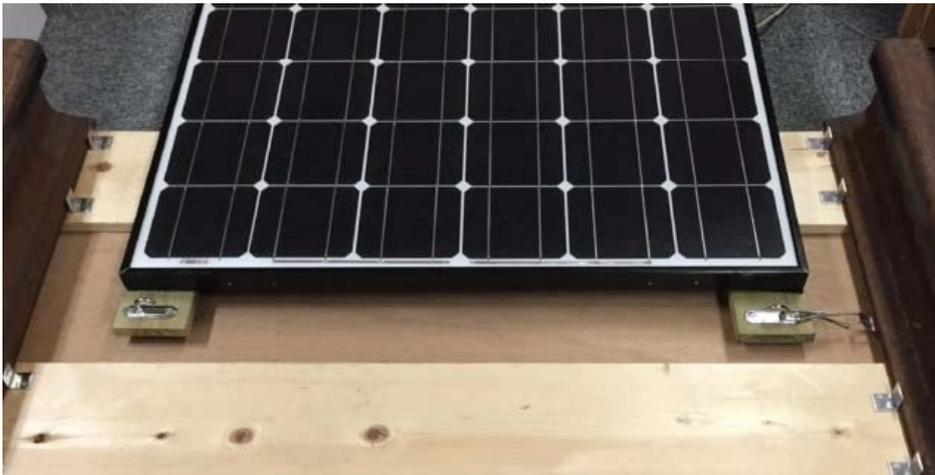
図 13.3 防腐剤注入した木材を絶縁材に使用した例
