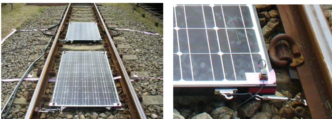
図 10.2 クッション材 20mm、直掛け（フック方式）のパネルの取付状況
